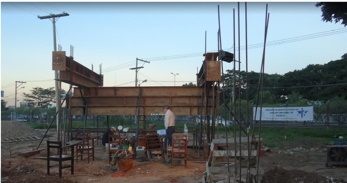
TP4, pilote Excavado y hormigonado bajo bentonita, 17,50 m de longitud, 450 mm de diámetro más un Expander Body de 600 mm de diámetro en la punta.
